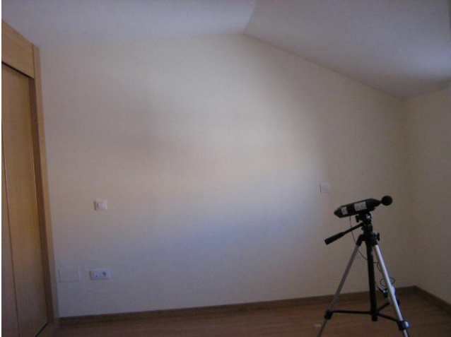
Imagen 3: Detalle de techo abuhardillado dormitorio 1 planta bajo cubierta.
